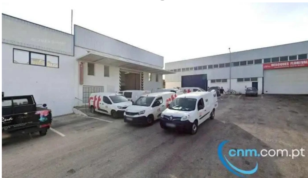
Ctt centro de distribuicao de lagos lagos
