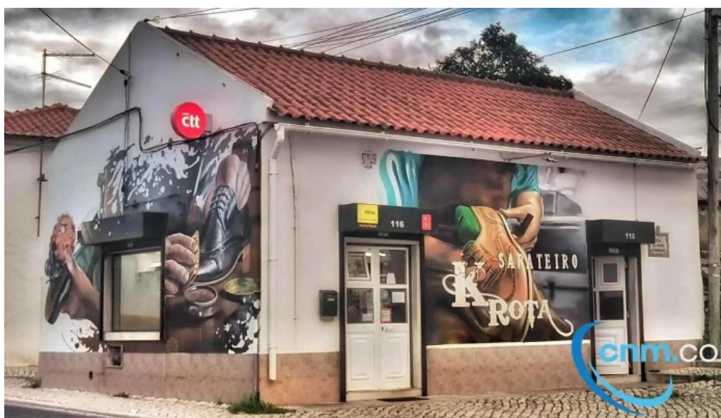
Ponto ctt terrugem do proprietario
