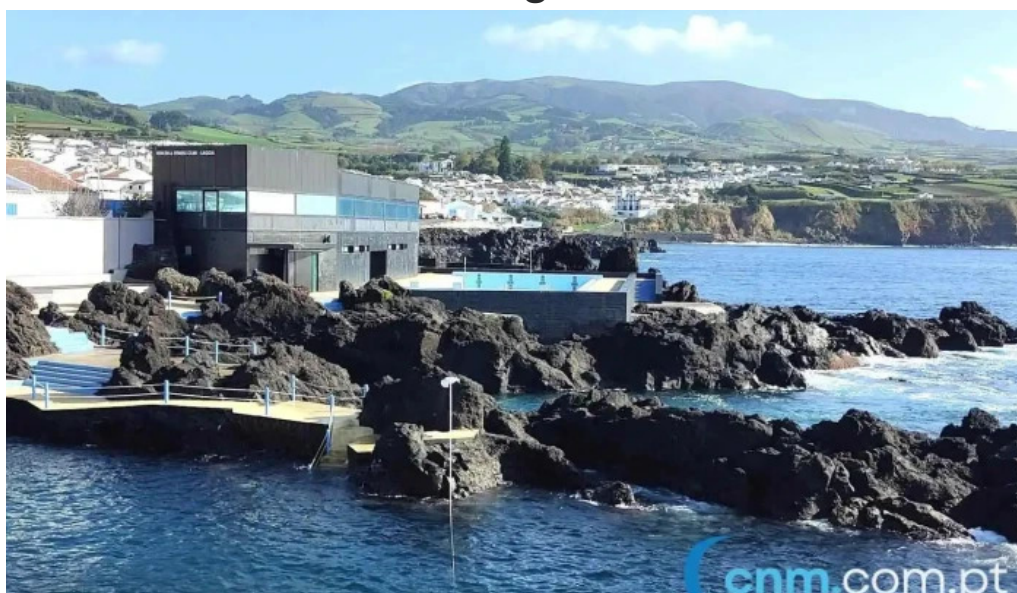
Complexo municipal de piscinas da lagoa lagoa
